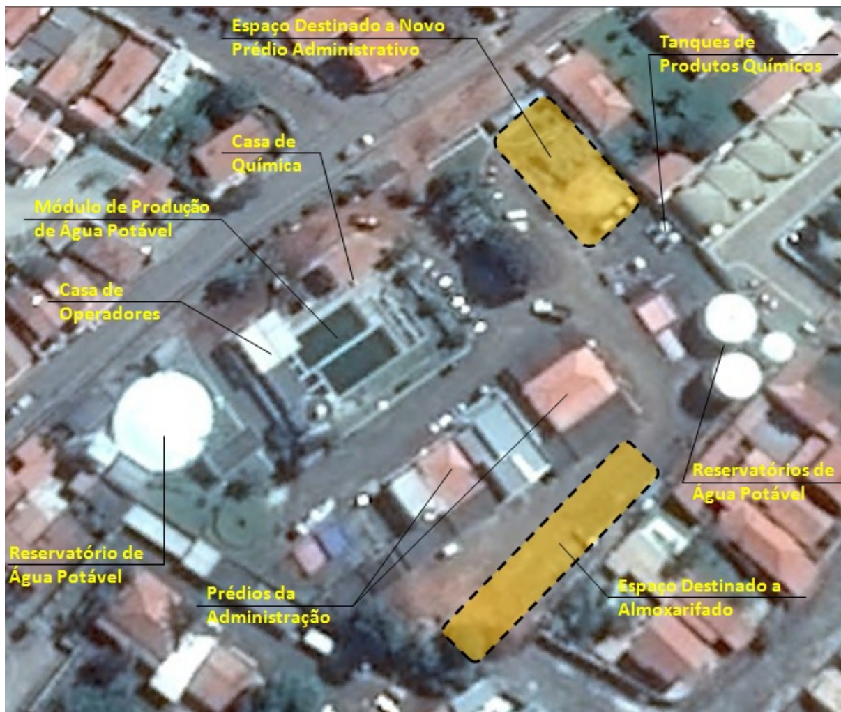
Figura 5.2 - Vista geral da ETA de Porto Feliz
