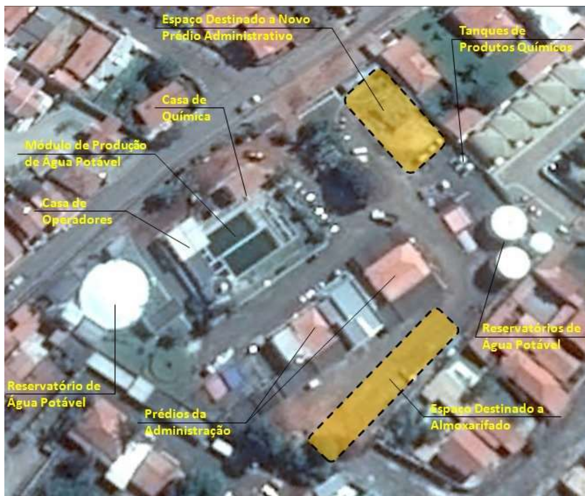
Figura 4.2 - Vista geral da ETA de Porto Feliz
