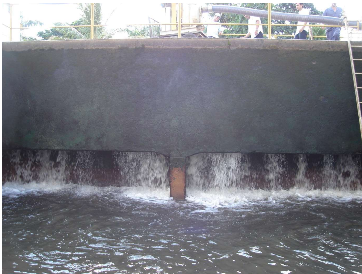
Figura 4.8 - Vista frontal da parede de entrada de água floclada no decantador. Foto tirada durante uma das operações de limpeza
