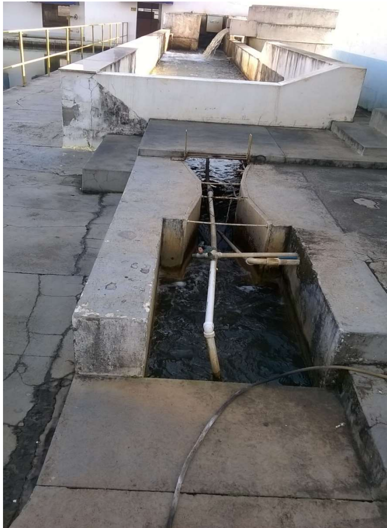
Figura 4.3 - Vista geral da estrutura de chegada de água bruta. Em segundo plano caixa de chegada e canal. Em primeiro plano, calha Parshall
